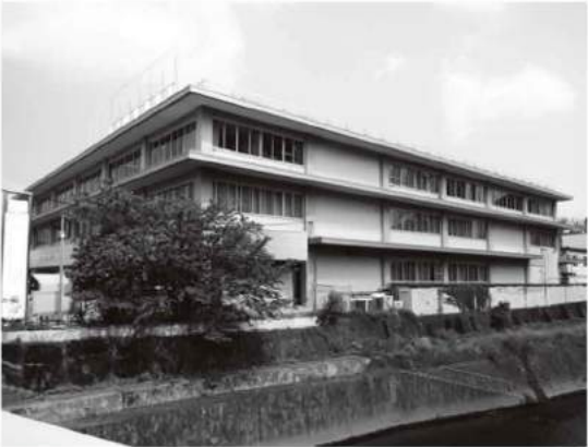
④建物③の全景（南立面・東立面）
