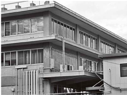
⑪北側外壁構面2階の増設壁（工事中）
