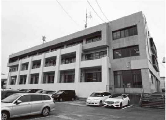
①建物②の全景（南立面）
