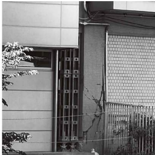
⑨鋼製支柱による応急補強（提供：蛸川利彦九州大学教授）
