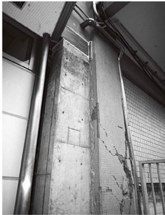
⑩増設袖壁による恒久補強（工事中）
