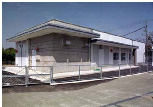
衝撃先端技術研究センターの外観
