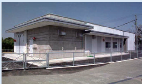
衝撃先端技術研究センターの外観
