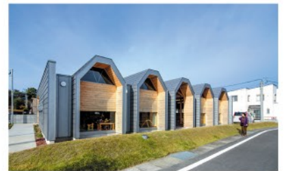
内田助教が設計した保育園。空調効率を上げるために天井高を低く抑えたことで、逆に圧迫感の無い個性的な保育空間を実現。空間の大きさを必要最小限に抑えることで建設部材も少なくて済み、結果的に周辺の住宅より安い坪単価で建設することができました。
