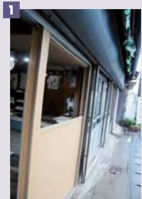
1 談議処(サテライト研究室)の2軒とりにある古民家の調査・研究をテーマにし……
